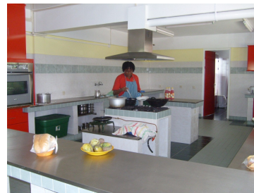
Tijdens de renovatie
